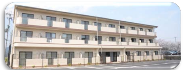
看護師宿舎H棟の1階がステーションです。
